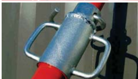
2. Orejeta para empuje y tracción
