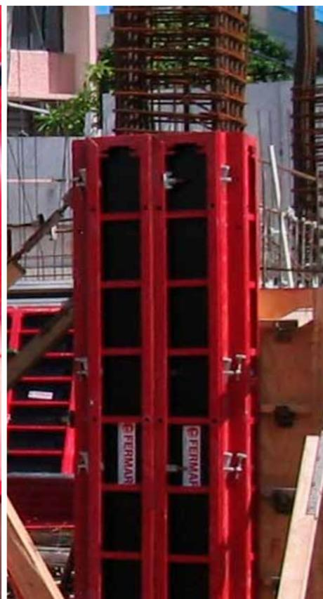
**Armazón Panel 2700x900 con tablero fenólico de 21 mm.**
