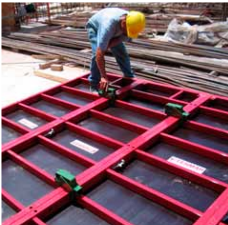
Paneles con Mordazas y Bulones / Pannel with clamp and wedge / Panneaux avec serrure et goupille
