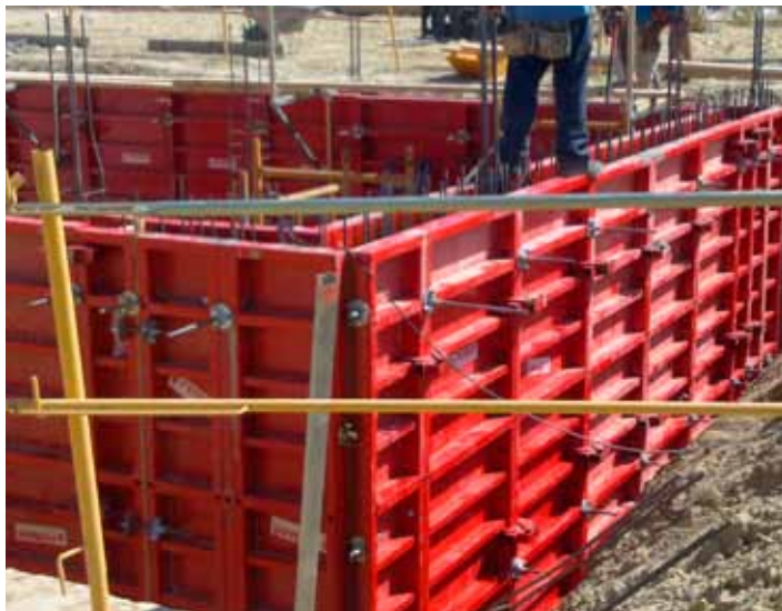
Muro a 2 caras para bodega soterrada.
