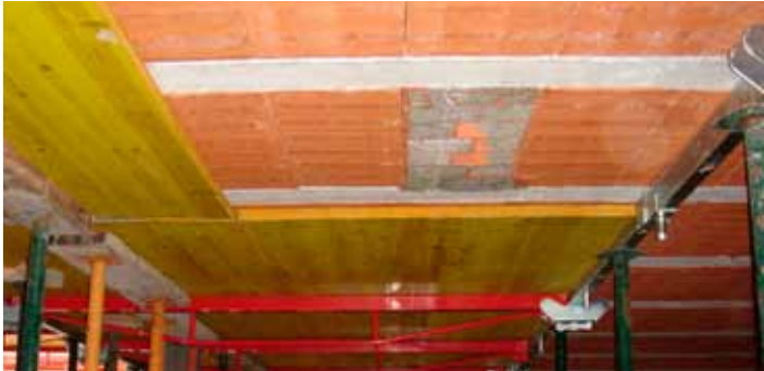
Desencofrado sin reapuntalamiento / Un-formwork without props reinforcement / Re-coffrage sans étaie
