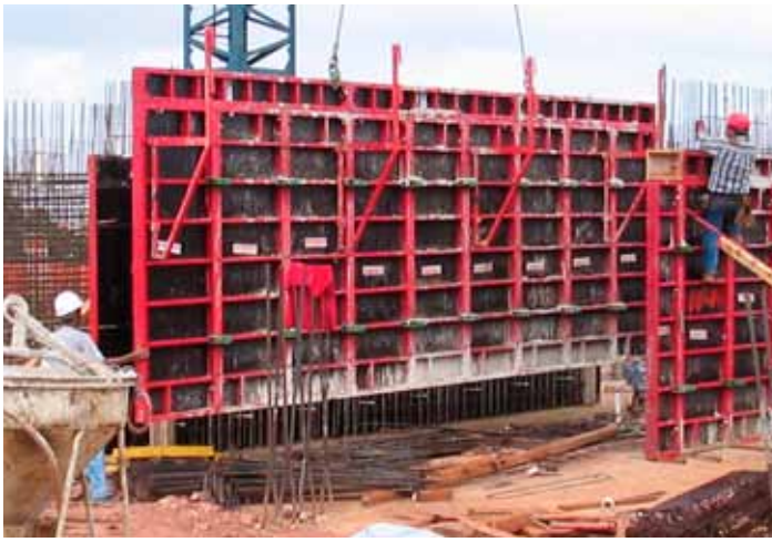
Manipulación de un muro de 24 m².
