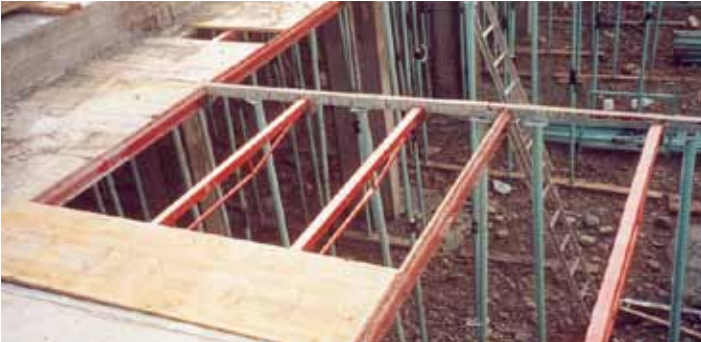
Desencofrado sin reapuntalamiento / Un-formwork without props reinforcement / Re-coffrage sans étaie
