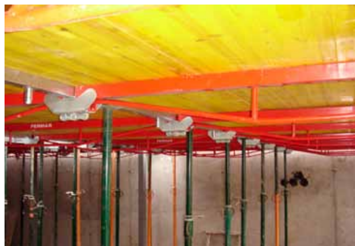
Unión de los cuatro elementos / Four elements union / Union des quatre elements
