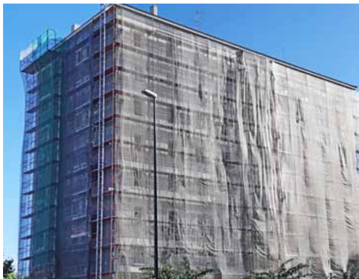
Fachada de andamio FER 48 haciendo esquina.
