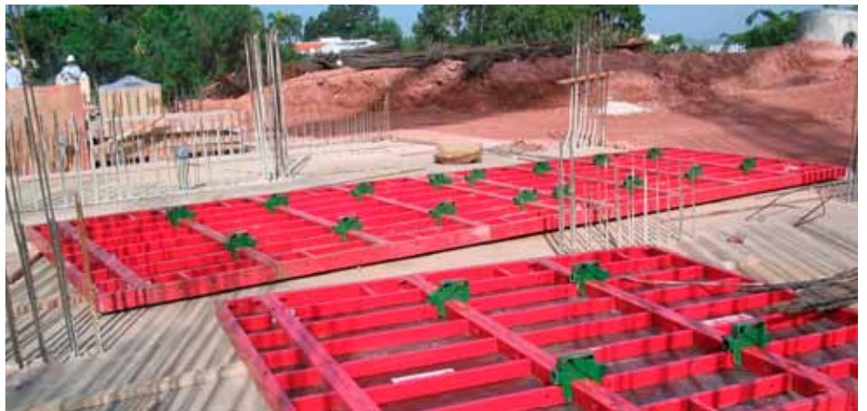
Paneles con Mordazas y Bulones / Pannel with clamp and wedge / Panneaux avec serrure et goupille
